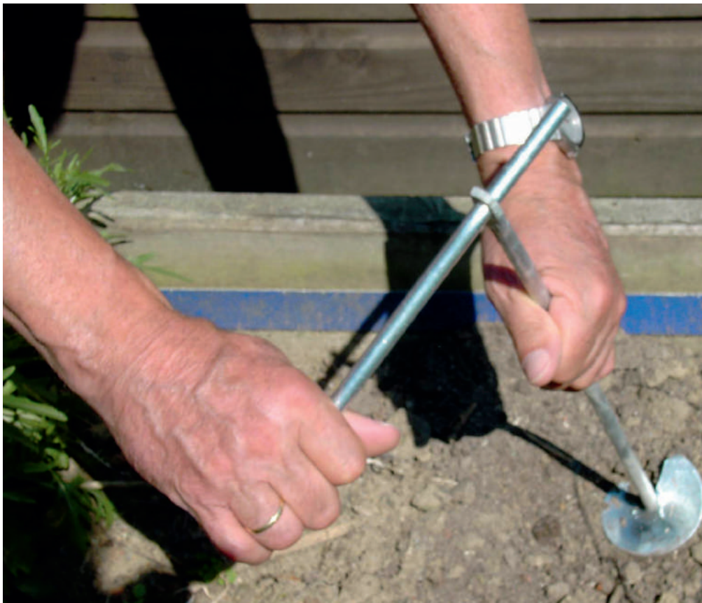
Eindreihen des ASS Erdankers mittels der Eindreihhilfe Use of the ASS Ground anchor by using the turn-in support
